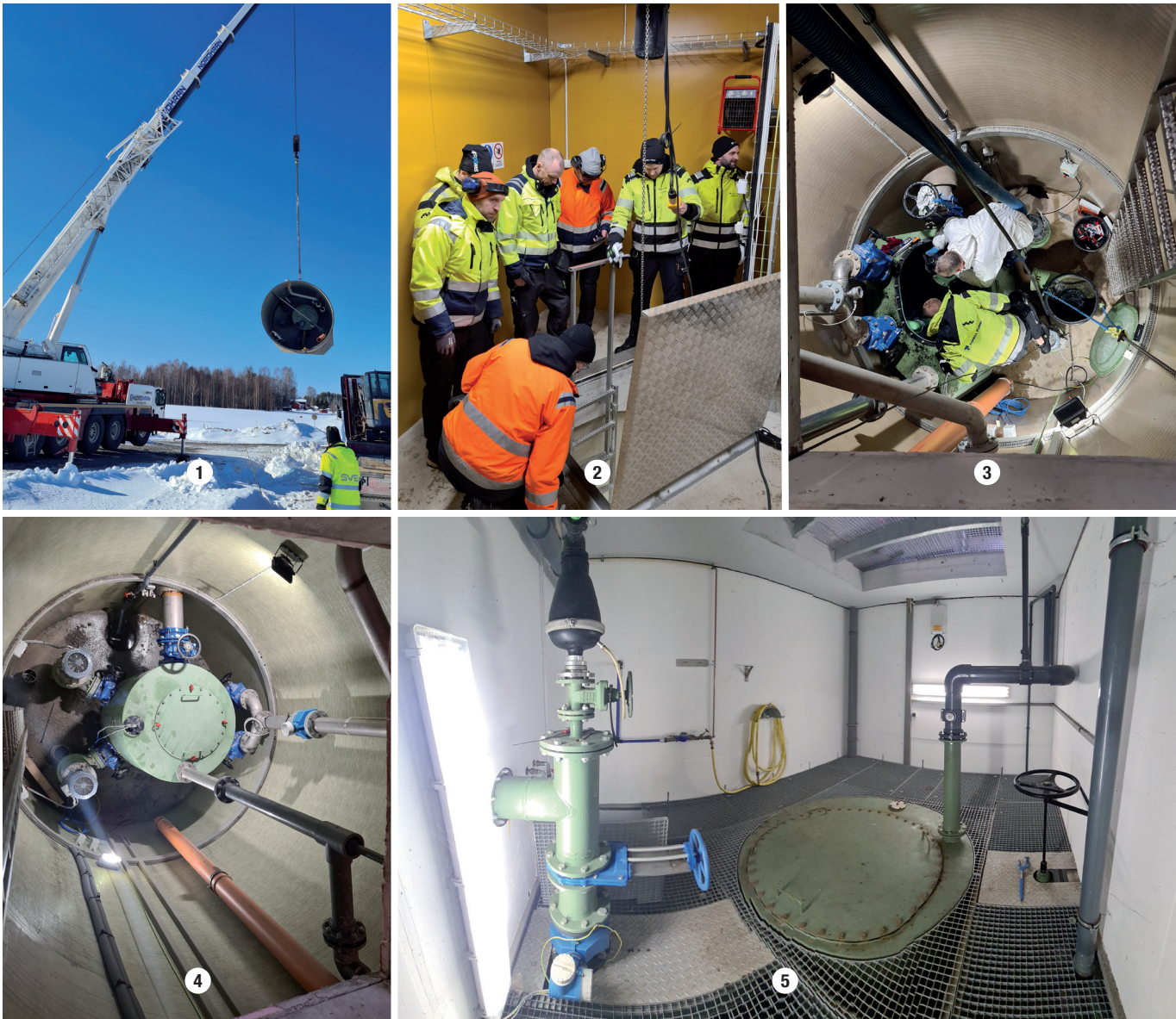
Bild 1: En Awalift lyfts på plats. Notera att själva pumpen sitter förmonterad i glasfiberbrunnen. Denna del av konstruktionen levereras färdig från Strate.
